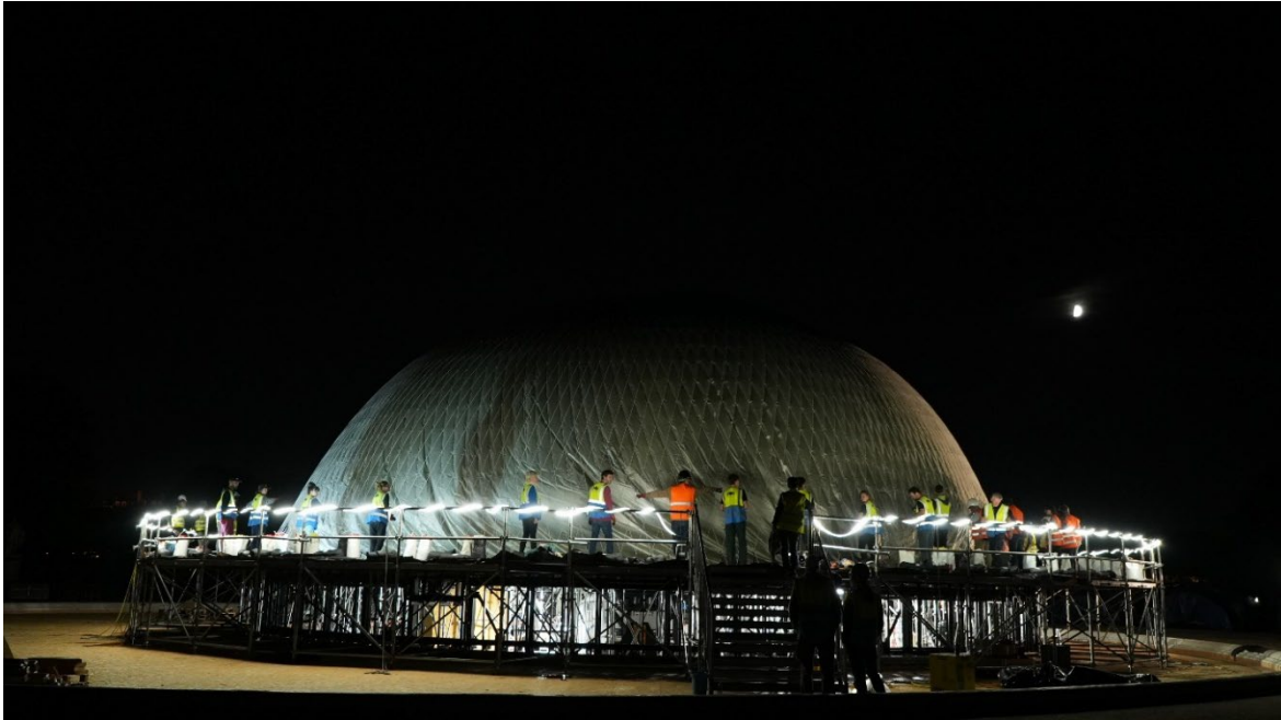
気球の組立（エアロフィルの厚意により）
